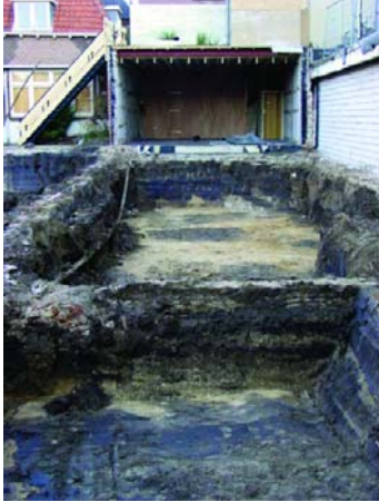
afbeelding 29, werkput met op de voorgrond de brede greppel.
